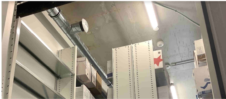
Figure 7 : Bâtiment 3, local archive, bouches non affleurantes
